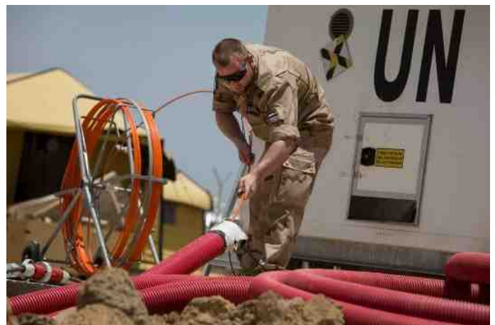
Een modern kampement vereist veel installatiewerk. Foto: Mindef
